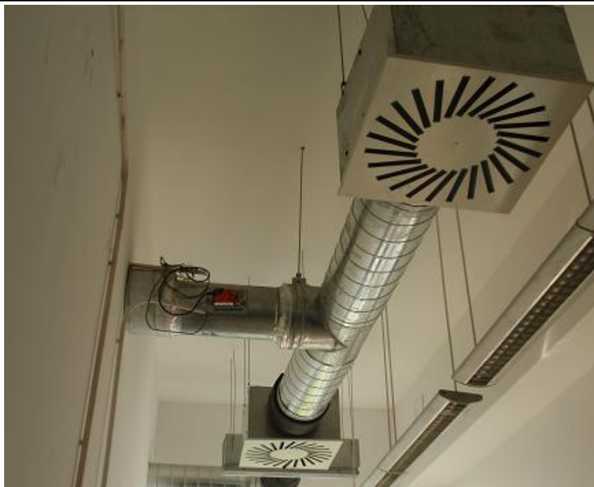
图 3.8 变风量末端与风阀执行器
