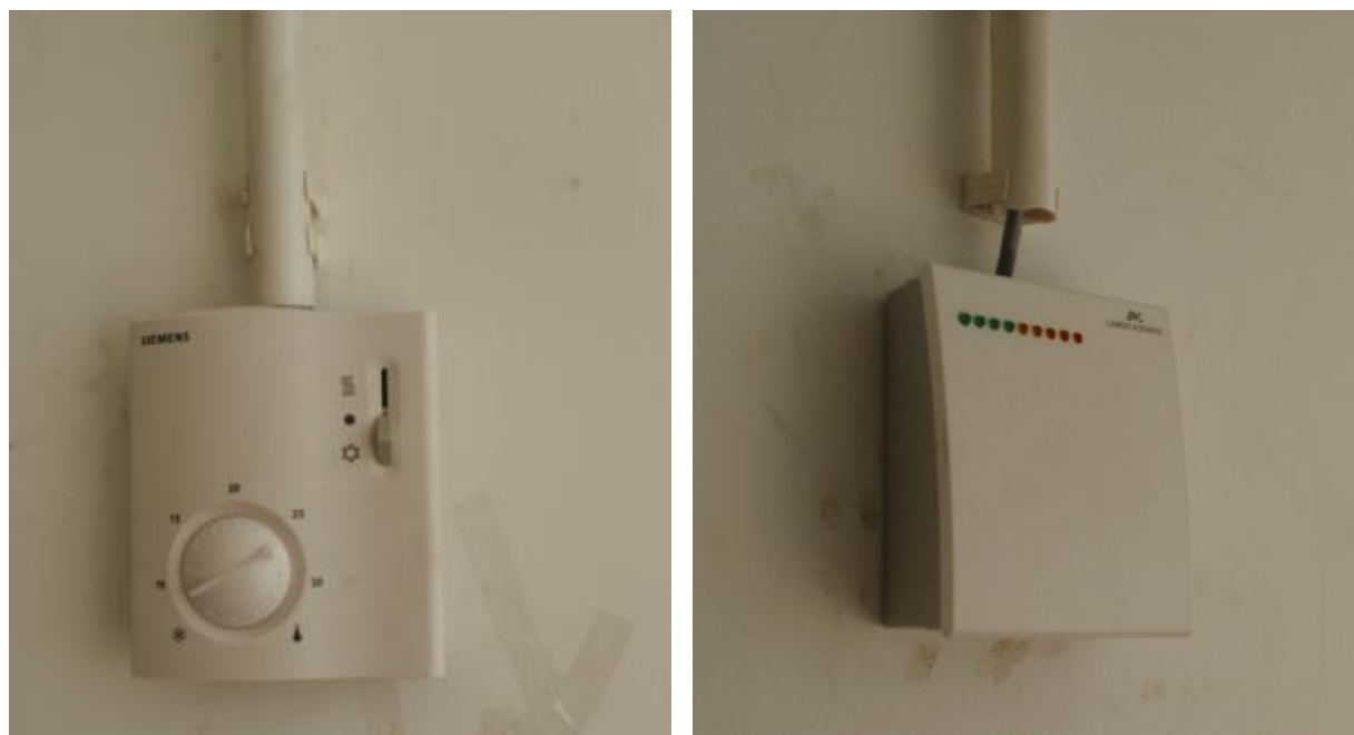
图 3.9 贴墙式室温控制其与室内二氧化碳传感器
