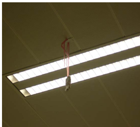
图 4.7 IT 设备回风侧温湿度传感器
